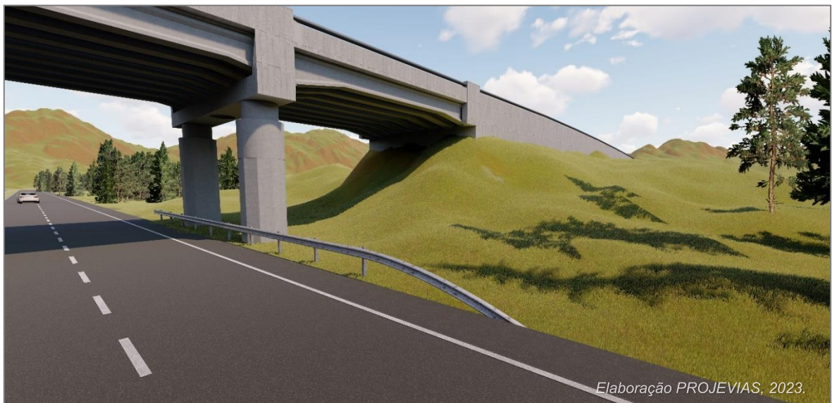
Figura 1 – Instalação Inadequada da Defesa Metálica.
